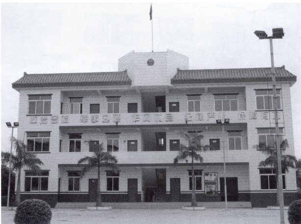
山口边防派出所办公楼
