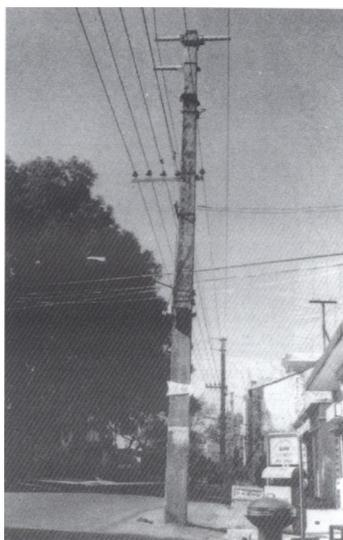
▲图 117 20 世纪 30 年代，城镇主干道安装的方形钢筋混凝土电杆
