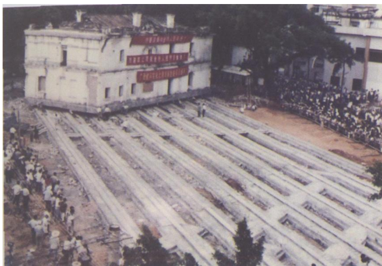
▲图 8 英国领事馆旧址平移过程
