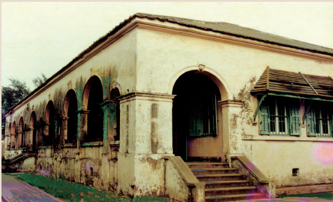
德国信义会教会楼旧址
