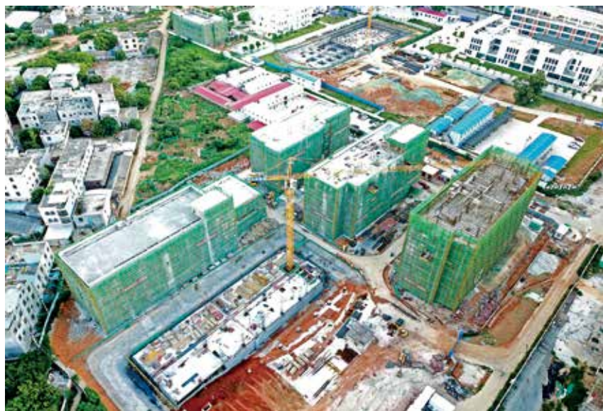
2021 年 6 月 7 日,银海区社会老年服务中心项目建设现场。
