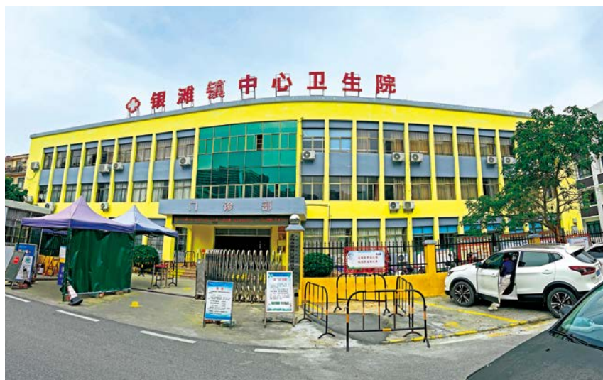
2021年,银滩镇中心卫生院扩建项目竣工投入使用。 区卫健局供
