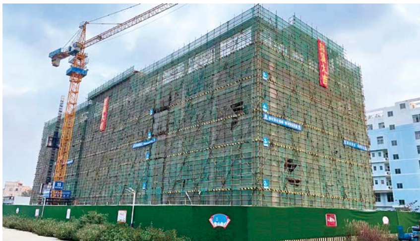
2021年,主体封顶的北海市银海区人民医院医技综合楼项目工程。
