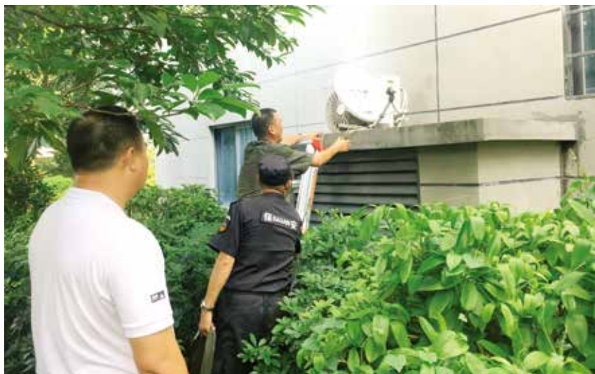
2019年8月28日,区文体广电旅游局检查小组工作人员在海韵佳园小区联合小区物业拆除业主非法安装的卫星电视广播地面接收设施
