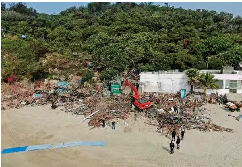
2021年3月12日,区“两违”办工作人员依法拆除冠头岭违章建筑商铺现场。 区交通城管局供
