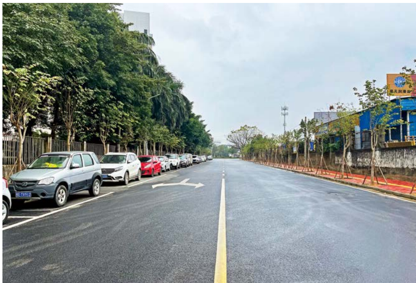
2021年7月3日,背街小巷提升工程——新国西路道路改造工程完成。
