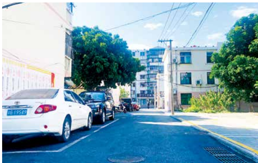
2020年9月26日,背街小巷提升工程——侨北社区侨北路西片区三巷道路改造工程。 区住建局供
