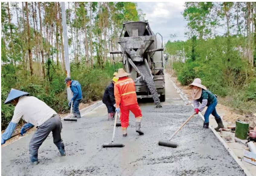
2021年11月6日,Y301青山一大陂(K2+470—K3.570段)路面提升工程浇灌混凝土施工现场。 区城管交通局供
