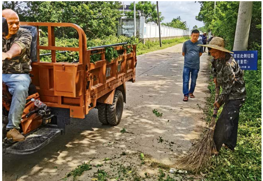
2021 年 6 月 21 日,区人防海防办组织人员对银海区新建海防执勤道路开展杂草清理、水沟疏通维护。 区人防海防办供
