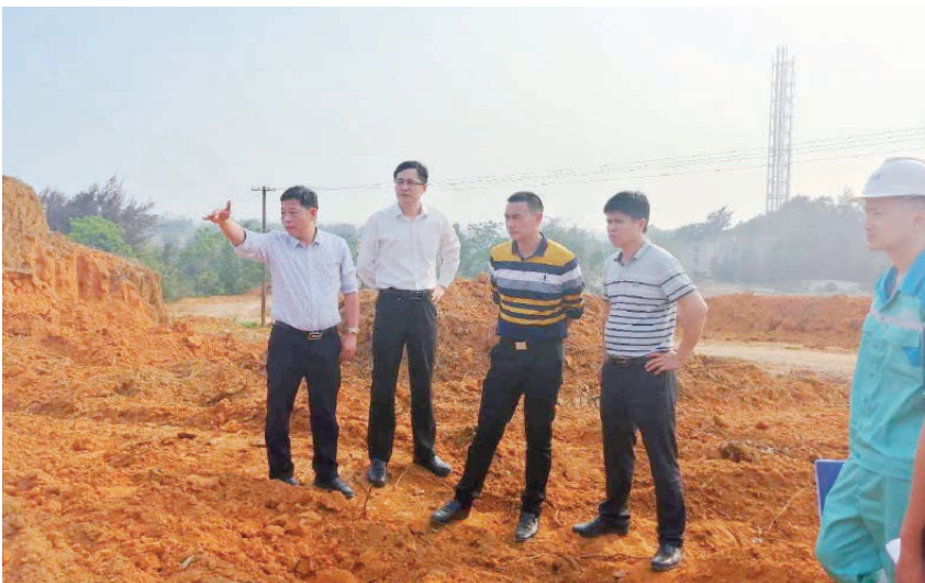
2019年3月22日,铁山港区委常委、副区长吴志全(左一)到铁山港区固体废弃物填埋场项目现场协调解决用地清场问题
