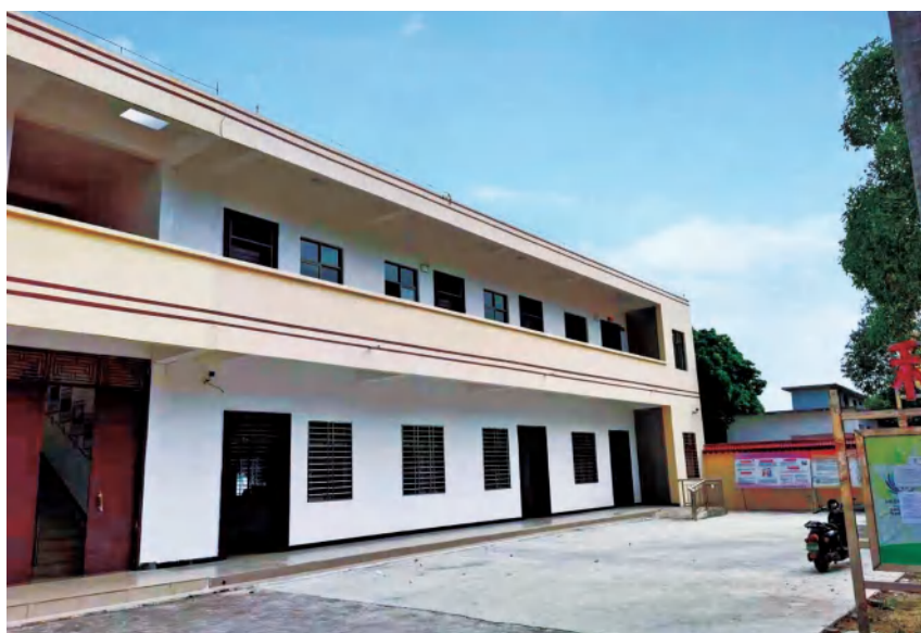
2020 年 4 月 30 日,铁山港区南康镇三塘村委民政服务中心建成投入使用
