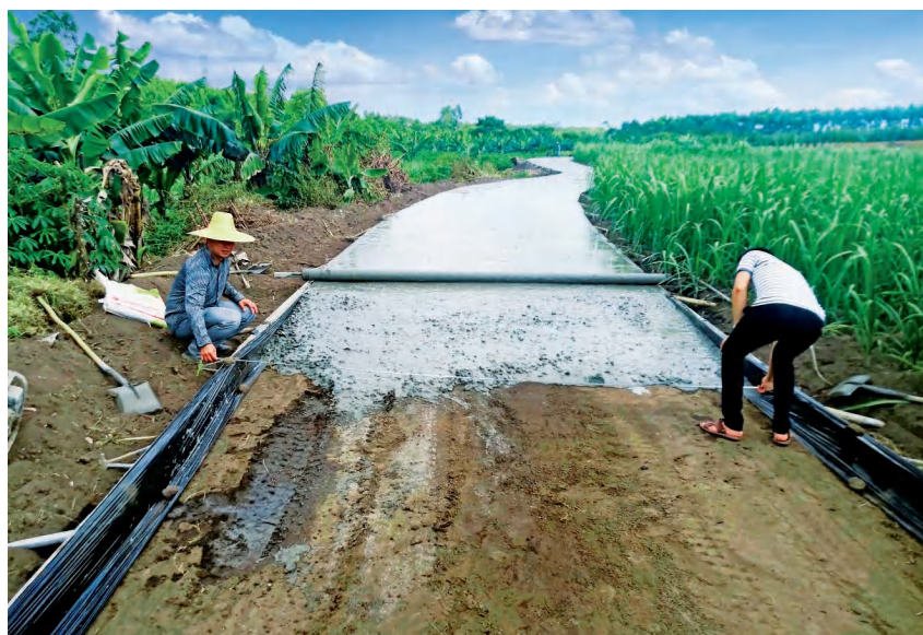
2020年6月1日,兴港镇大树岭村委罗屋村水库移民生产道路项目建设现场 区扶贫移民局 供
