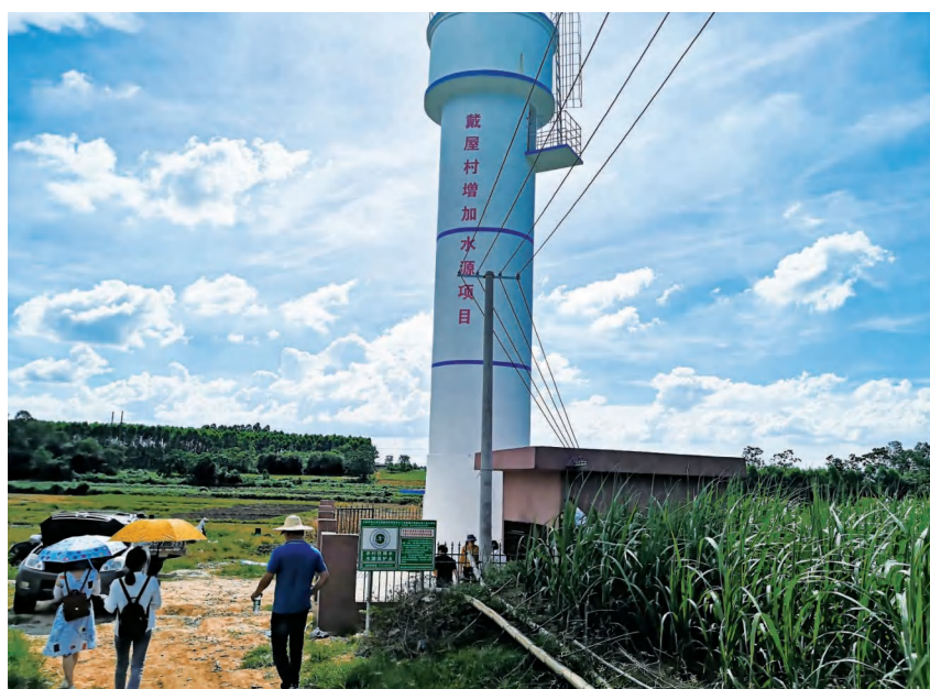
2020 年 5 月 14 日,建设完工的南康镇黄丽窝村委戴屋村增加水源项目工程外景 区农业农村和水利局 供
