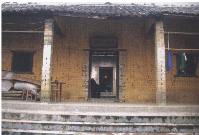
潘屋印刷厂正面
