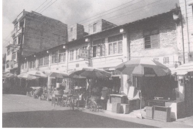
往昔博爱路（今新中路）的“十房铺”（图中的一排两层老屋，其中有三间已折旧屋建新楼）
