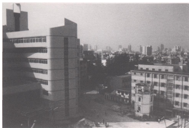
昔日“鹤立鸡群”的八角楼，与今日拔地而起的市人民医院新门诊大楼相比，已相形见绌了
