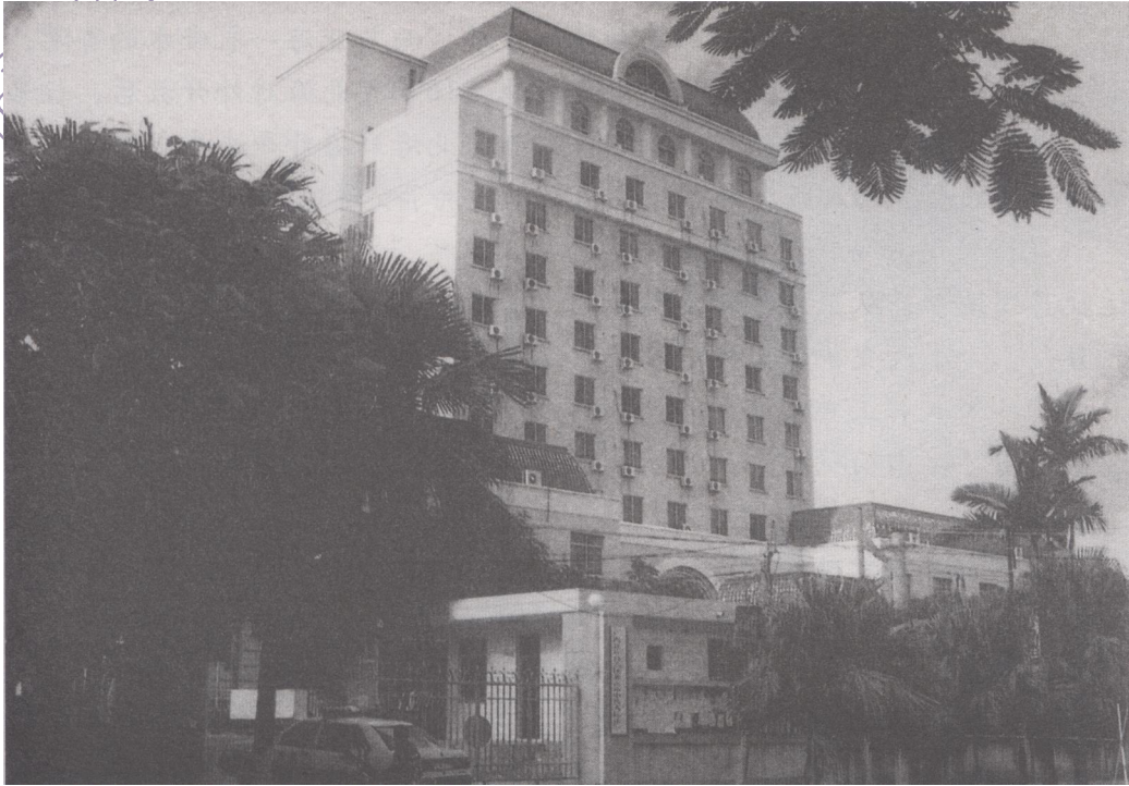
位于茶亭路西端的北海市中级人民法院有近百年的历史，是我国早期与国际司法接轨的老法院之一。 图为于1999年在北海老法院旧址建成使用的北海市中级人民法院审判厅大楼
